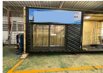
(d) ผลิตภัณฑ์ประตูที่ทำการติดตั้ง
