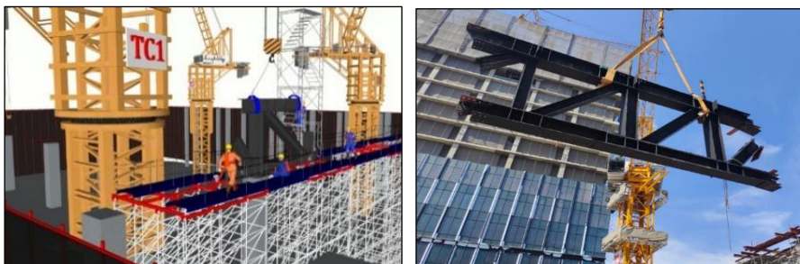
ภาพ2. การจำลองการติดตั้งอุปกรณ์กันตก และ การผูกมัดชิ้นงาน
