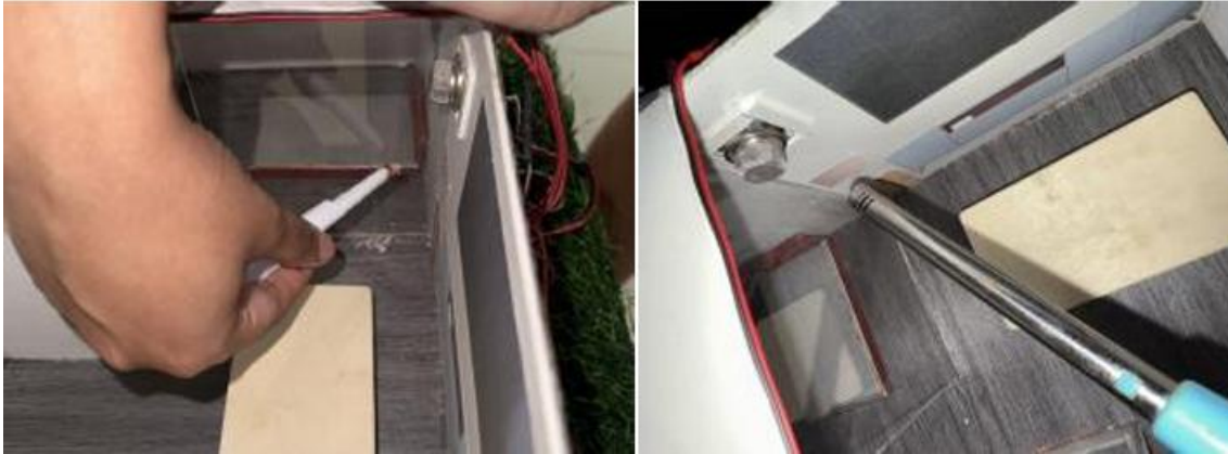
รูปที่ 11 การทดสอบระบบตรวจจับวัตถุไวไฟและควันจากอุปกรณ์จุดไฟจากแก๊ส
