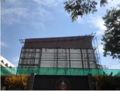
ภาพการปรับปรุงอาคาร 3
